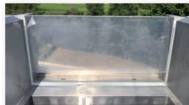
Basen na dachu hotelu z przednim panelem przejrzystym z akrylu (wykonawca PEK-MONT)
