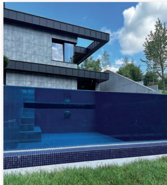
Basen z płytą akrylową wystającą powyżej linii wody mocowaną w trzech punktach podparcia (wykonawca Bel Tempo Spa)
