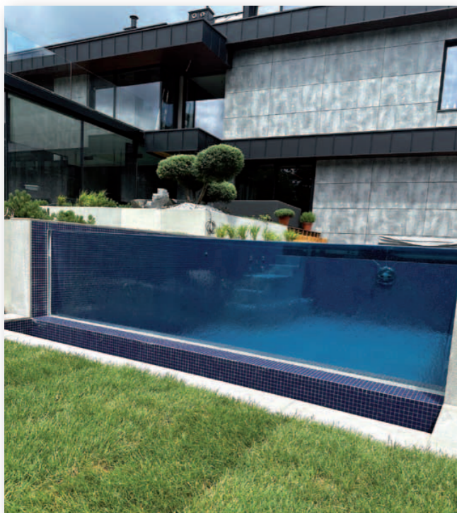
Basen z płytą akrylową wystającą powyżej linii wody mocowaną w trzech punktach podparcia (wykonawca Bel Tempo Spa)
