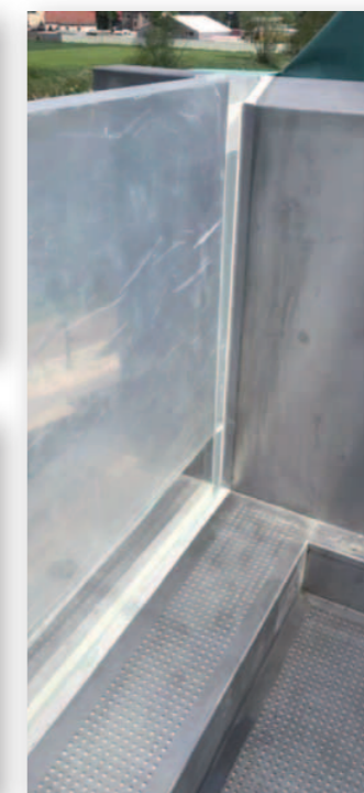
Basen na dachu hotelu z przednim panelem przejrzystym z akrylu (wykonawca PEK-MONT)
