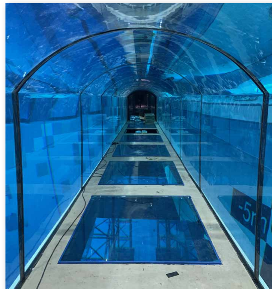
Tunel w najgłębszym basenie na świecie w Mszczonowie pod Warszawą – tafle szklane wykonane ze szkła zespolonego w postaci trzech tafli gr. 15 mm każda
