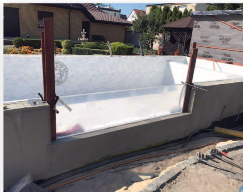
Basen wolnostojący z zamocowanym w ścianie bocznej panelem akrylowym (wykonawca PEK-MONT)
