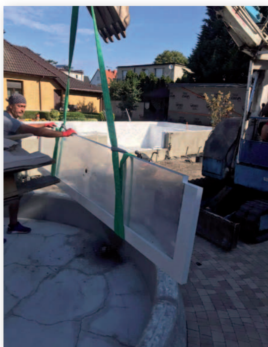
Basen wolnostojący z zamocowanym w ścianie bocznej panelem akrylowym (wykonawca PEK-MONT)
