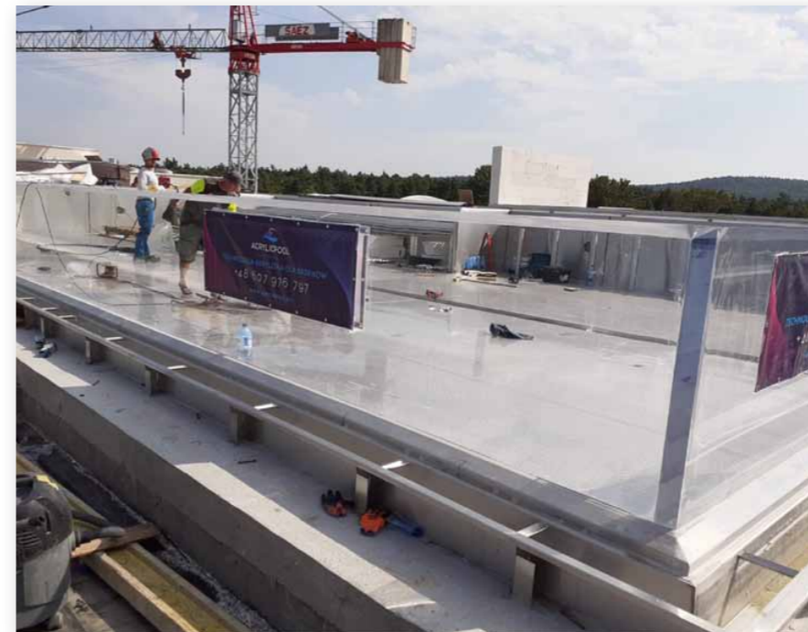
Basen na dachu hotelu Binkowski w Kielcach – w ramach realizacji wykonano klejenie licowe dla panelu akrylowego gr. 110 mm (wykonawca PEK-MONT)
