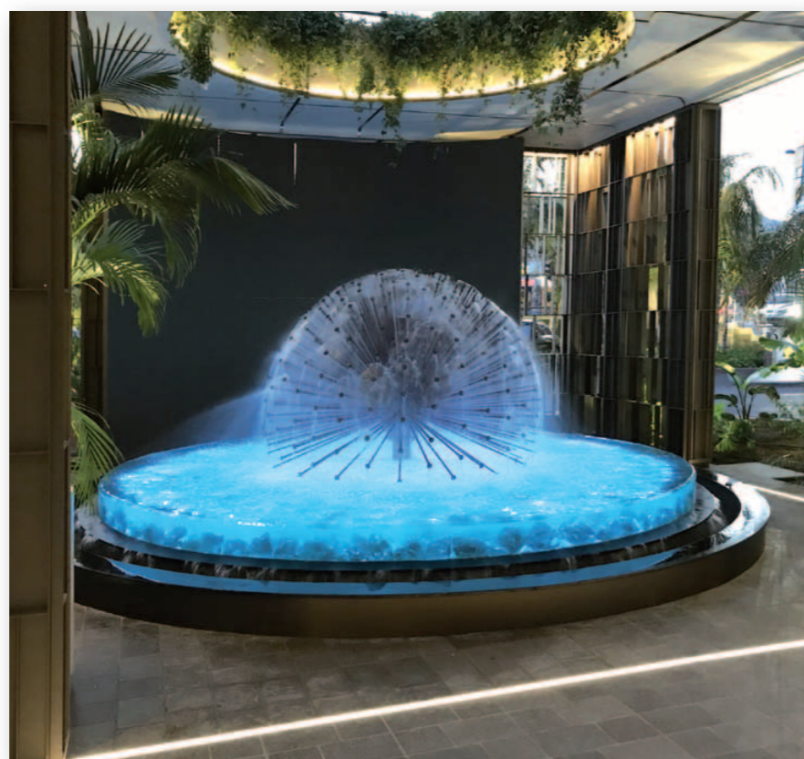
Fontanna z przelewem z termoformowanego akrylu w luksusowym hotelu na Cyprze
